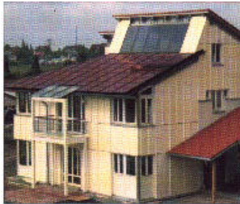
Figura 5 – Exemplo de utilização de painéis fotovoltaicos incorporados a arquitetura de uma edificação qualquer. Fonte: RUTHER (2001).
